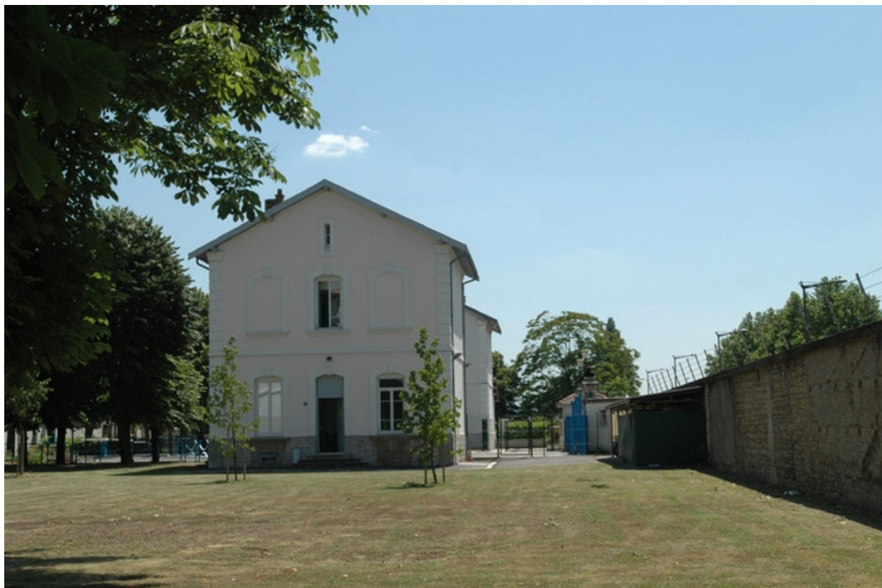
Pignon du bâtiment n° 59
