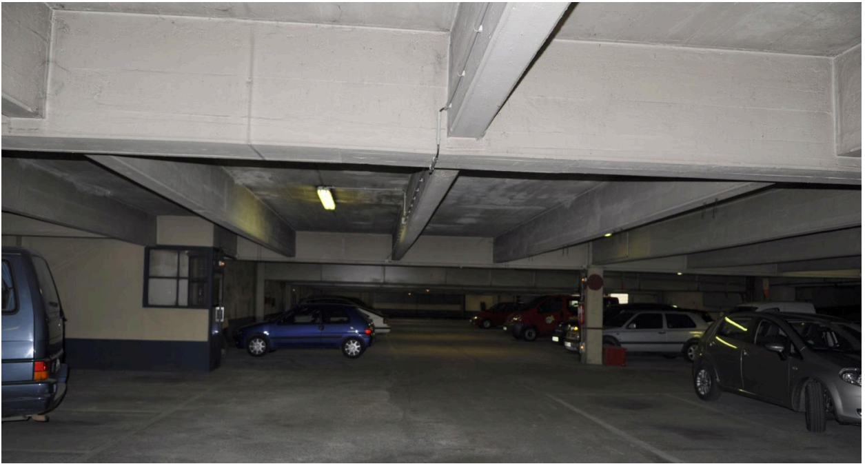
Vue intérieure du parking souterrain
