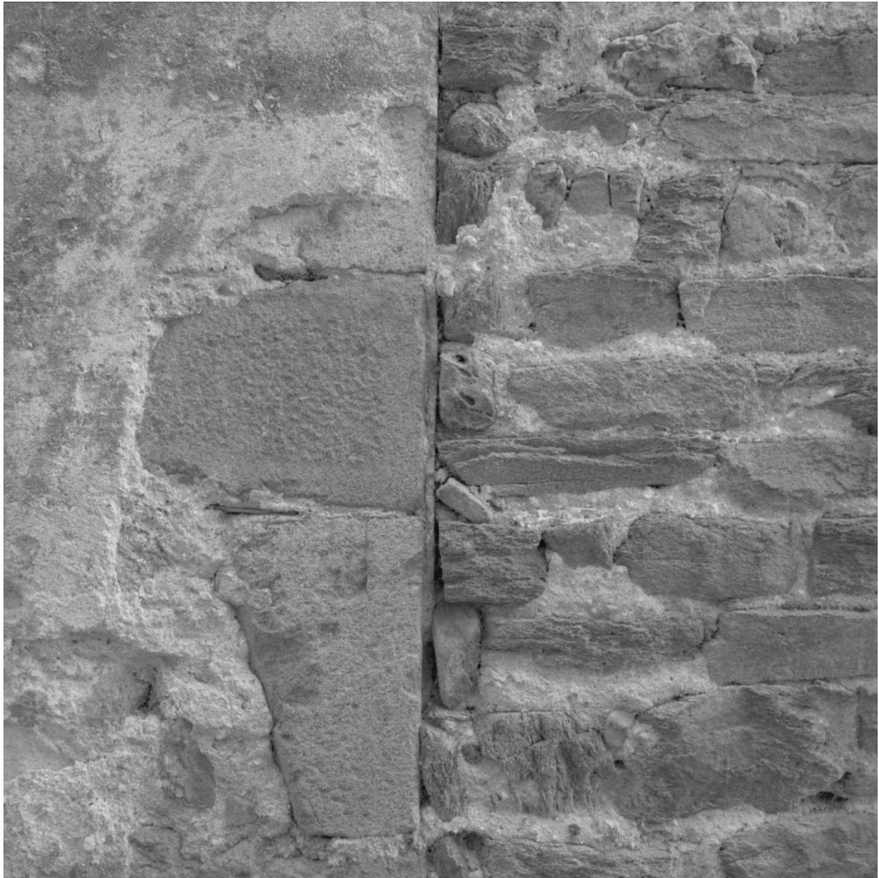
Détail de la façade ouest : jonction entre le bâtiment primitif et le pavillon rajouté ; l'enduit original, avec un faux appareil rose, est visible entre les deux.
