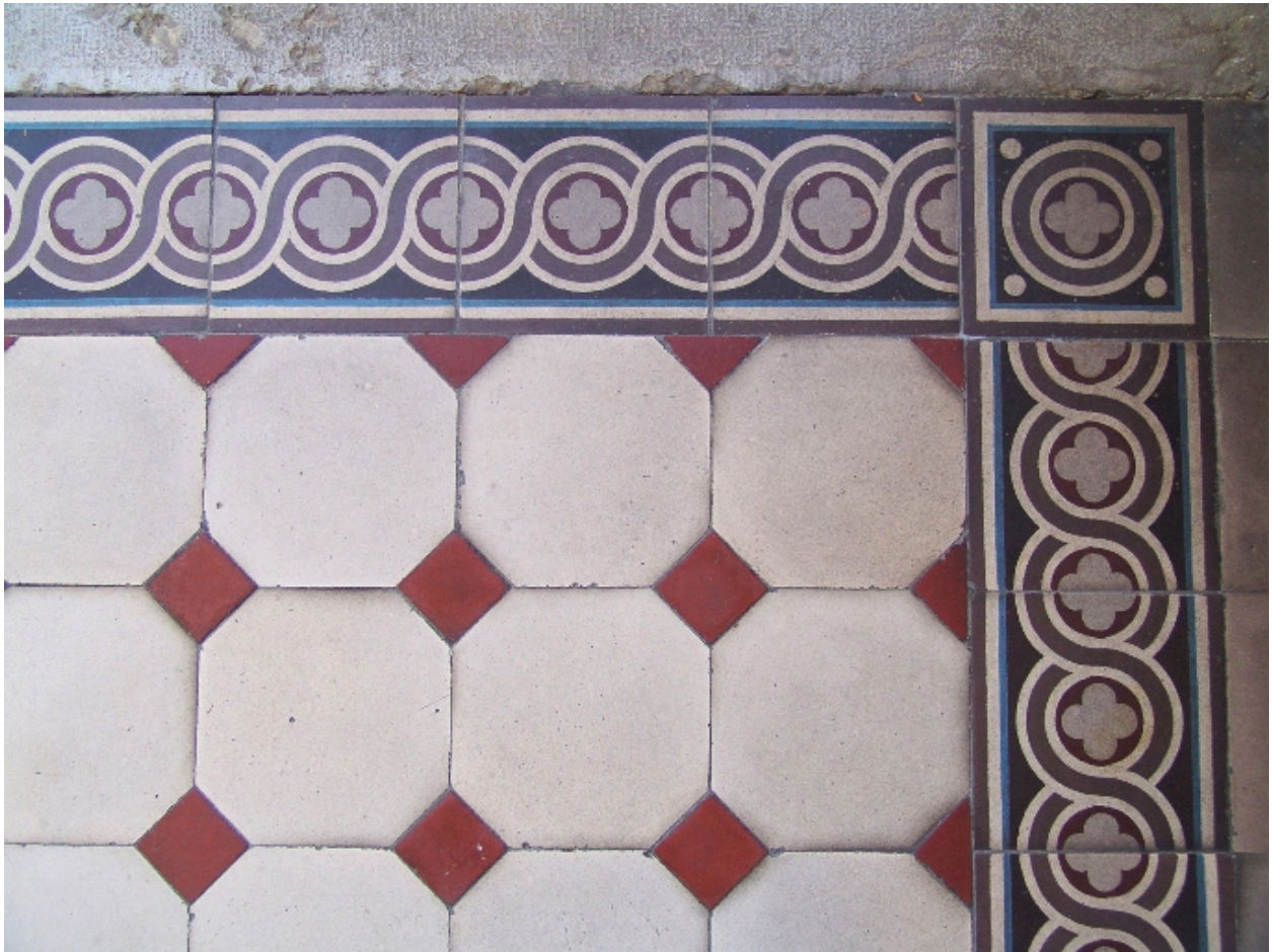
Détail du carrelage du hall
