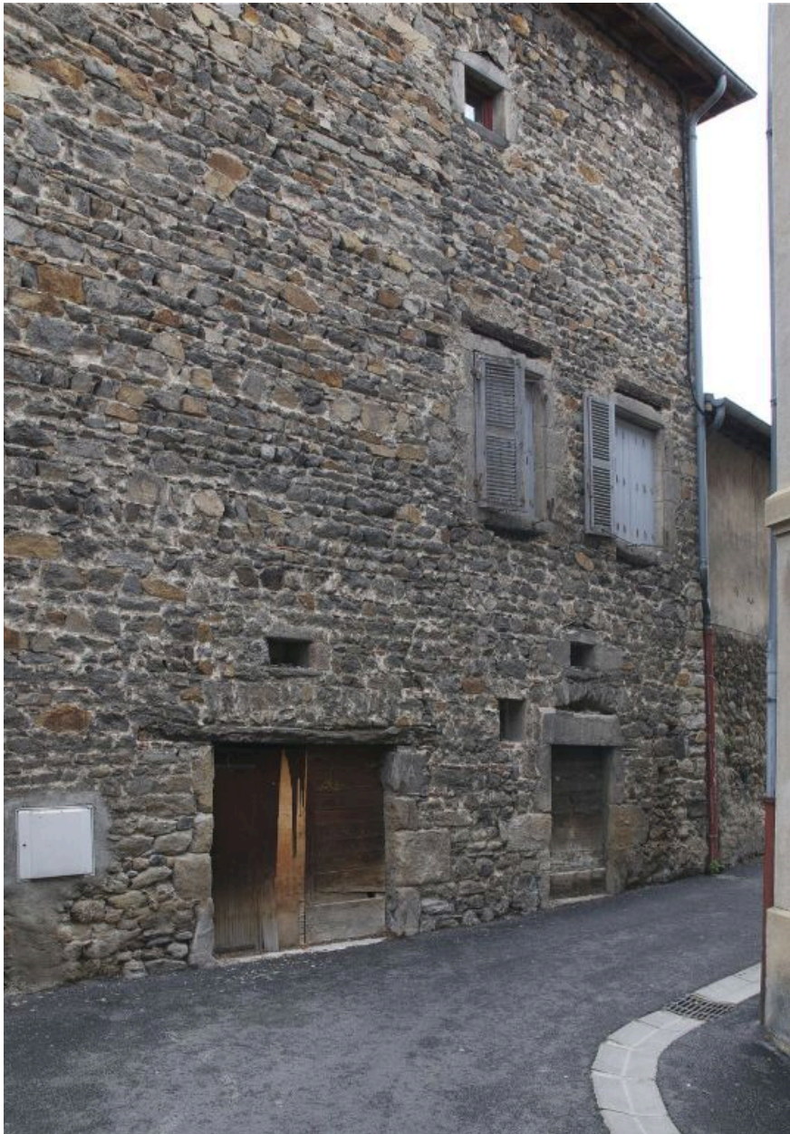
Elévation postérieure donnant sur la rue Montabembert.
