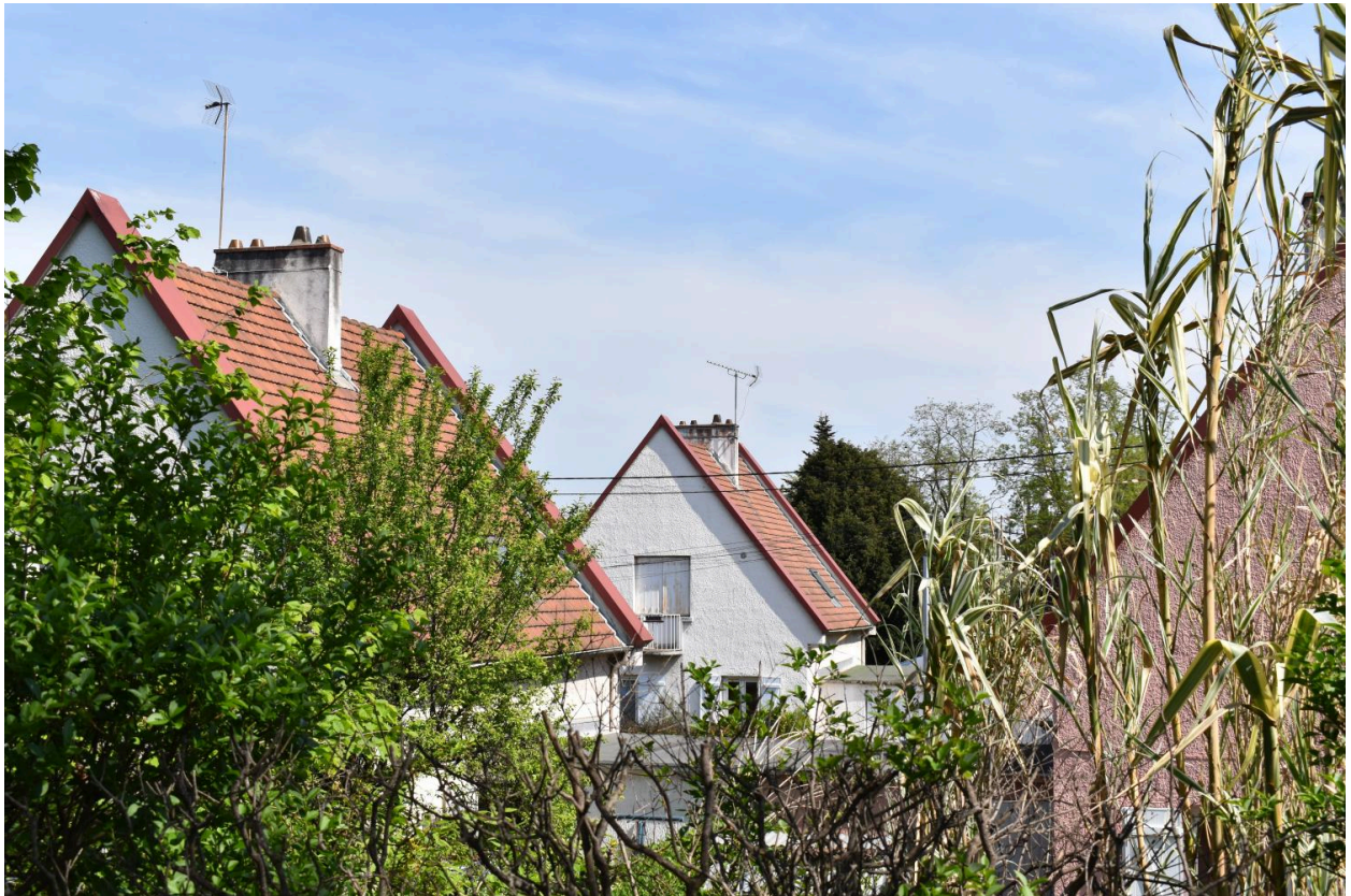
Cité ouvrière P.L.M. dit des Cigognes vue depuis la rue Jean Vilar
