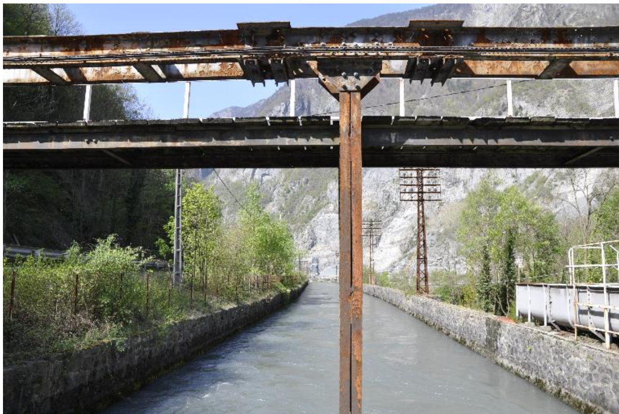
Vue du barrage de Rioupéroux
