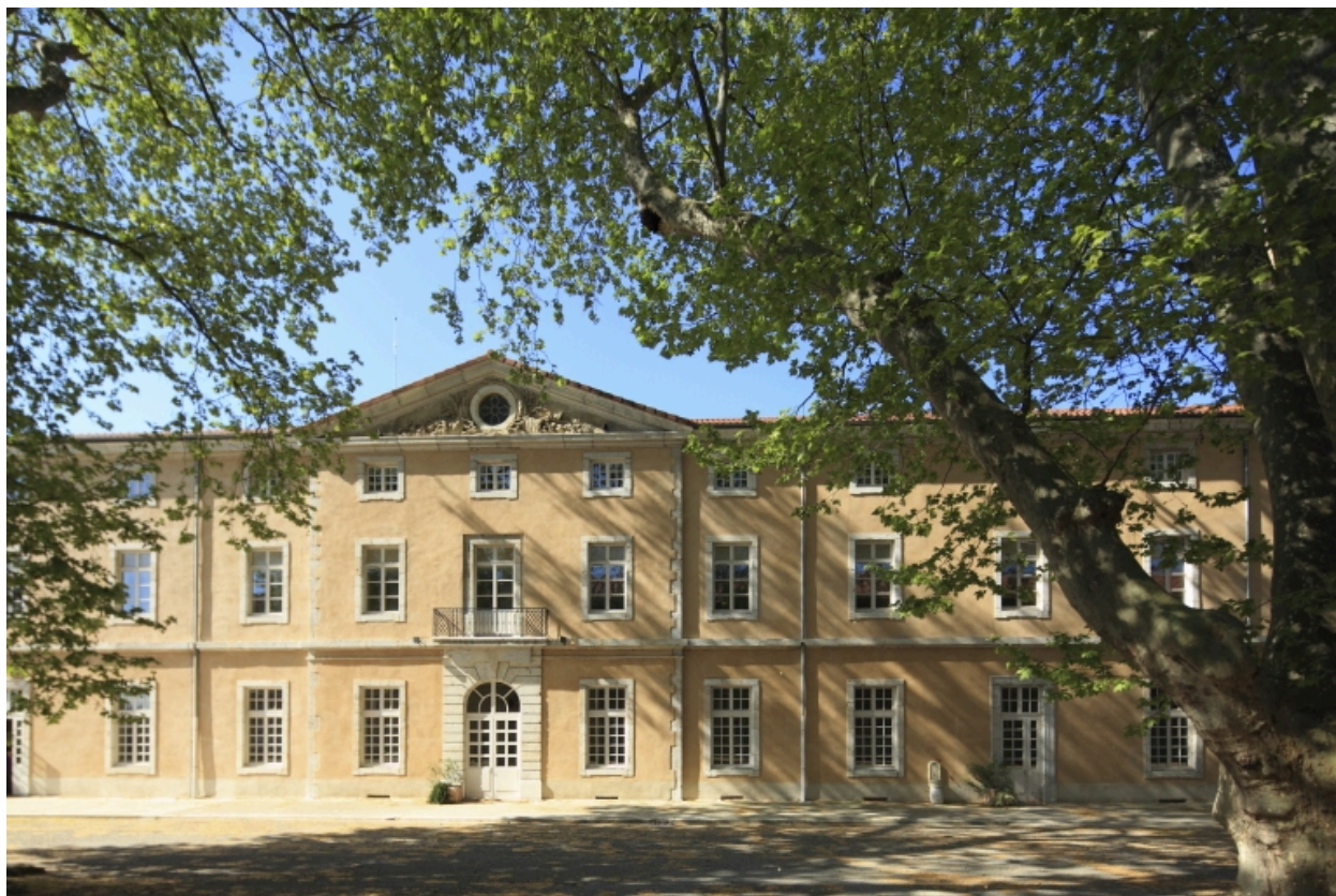
Bâtiment C. Cour intérieure sud. Façade orientale.
