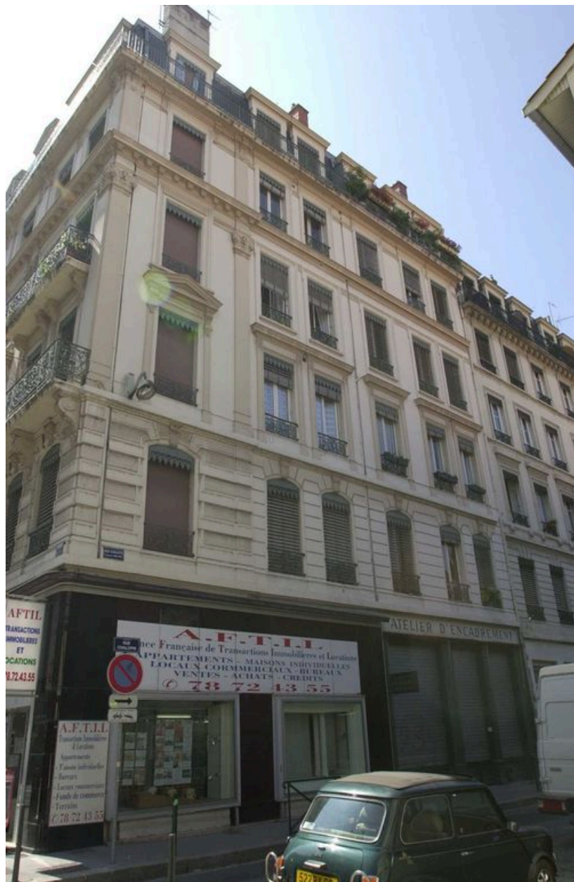
Vue d'ensemble de la façade rue Chalopin
