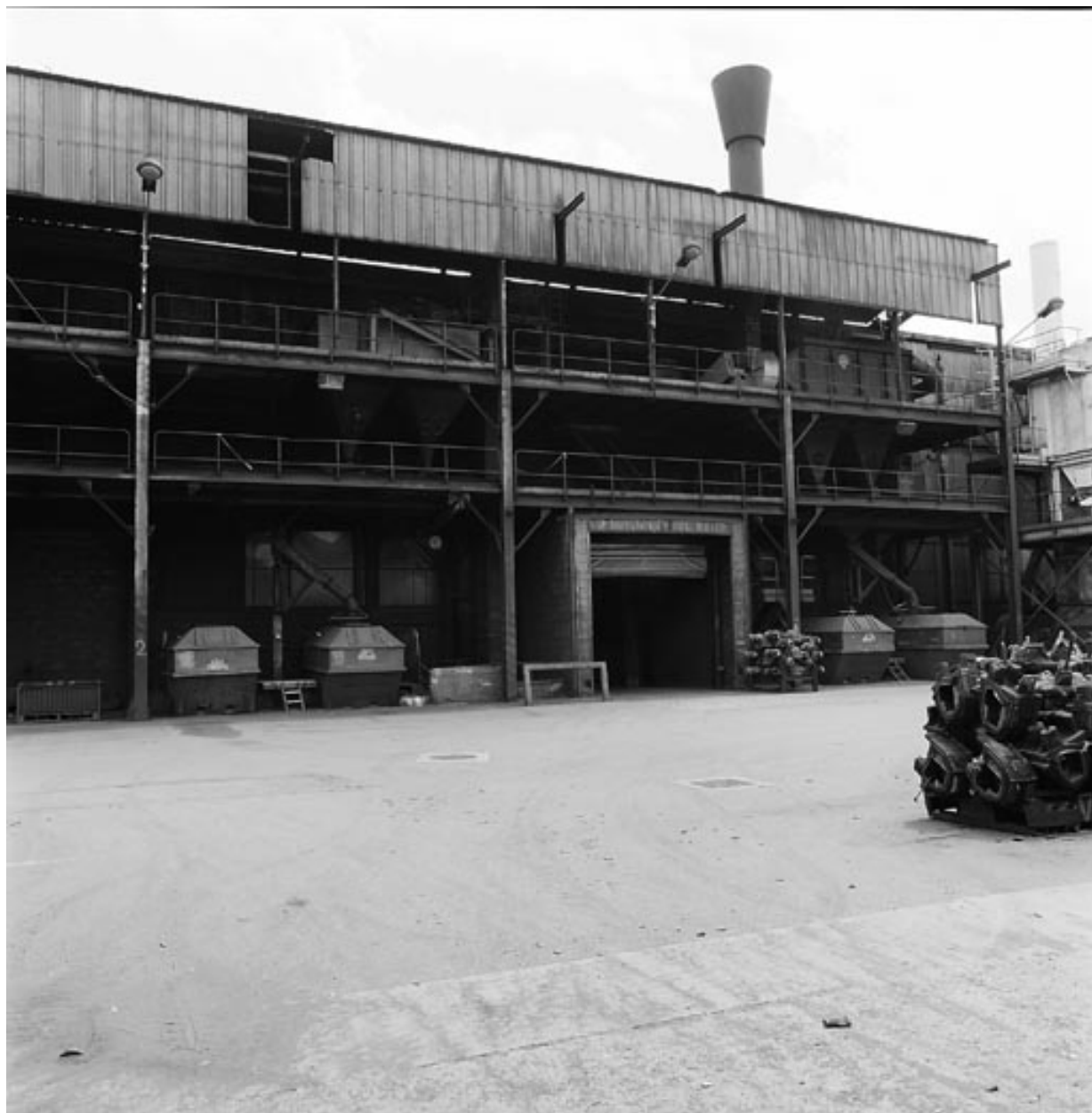
Fonderie, vue est, entrée parachèvement sud.
