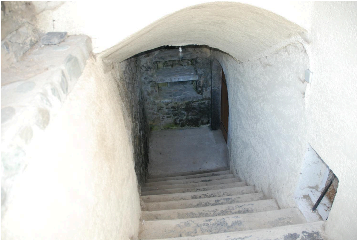
Ferme (2018 H2 543 à 547). Habitation (544), couloir voûté d'accès aux caves.
