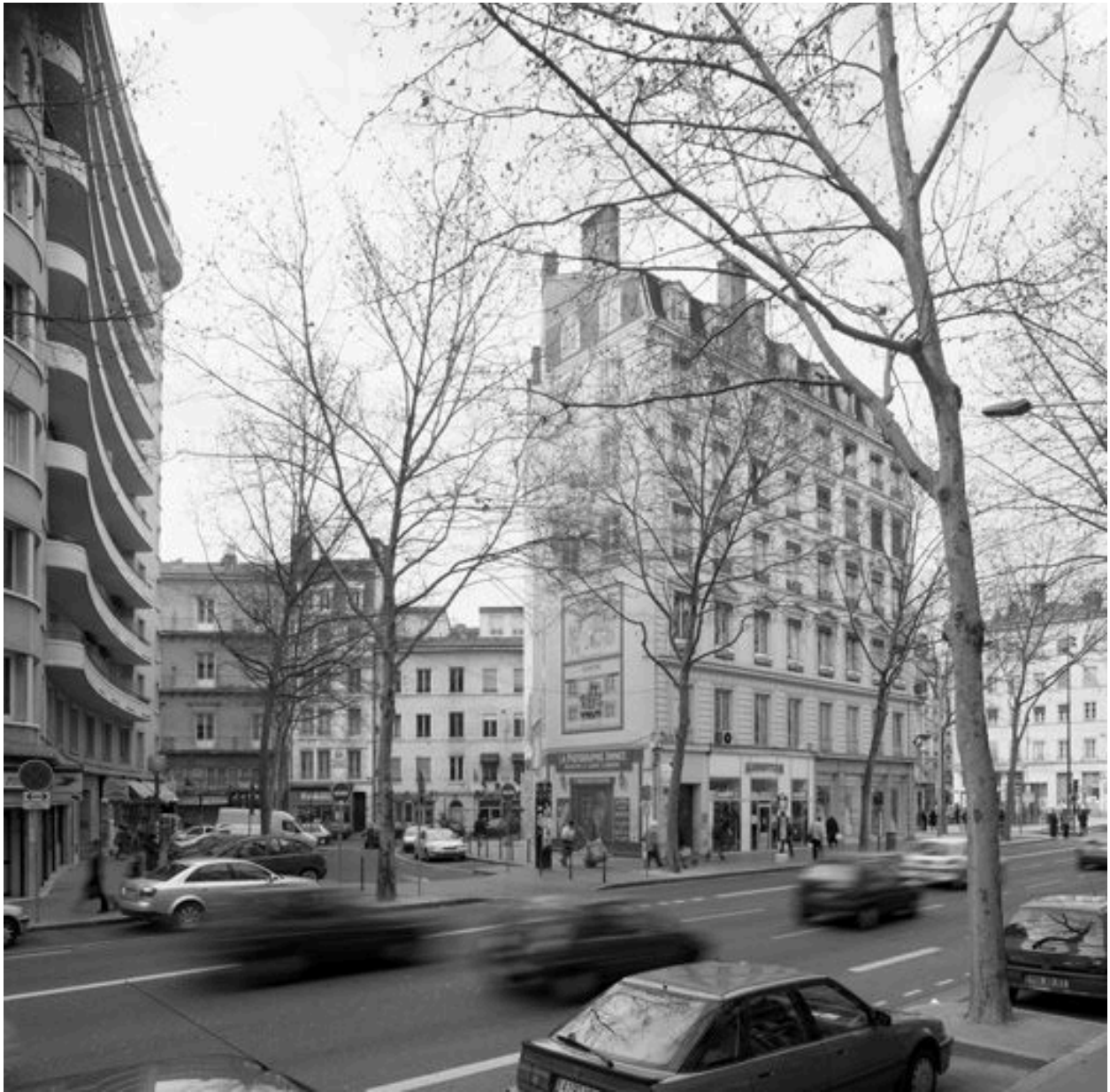
Élévation principale depuis l'ouest
