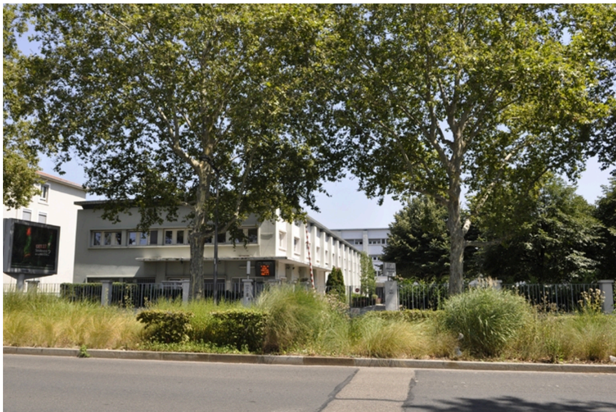
Vue de bâtiments construits dans les années 70 depuis l'avenue Leclerc.
