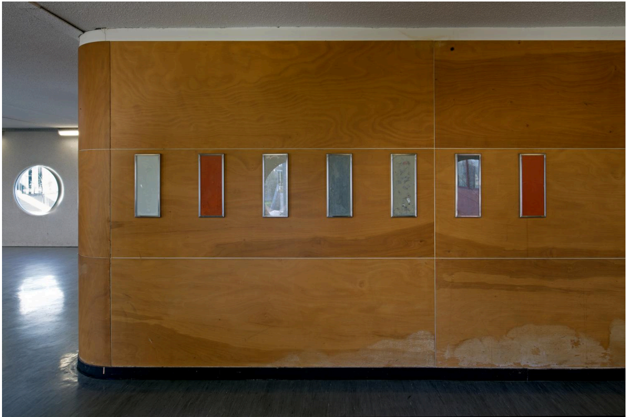
Mur n° 4, vue d'ensemble.
