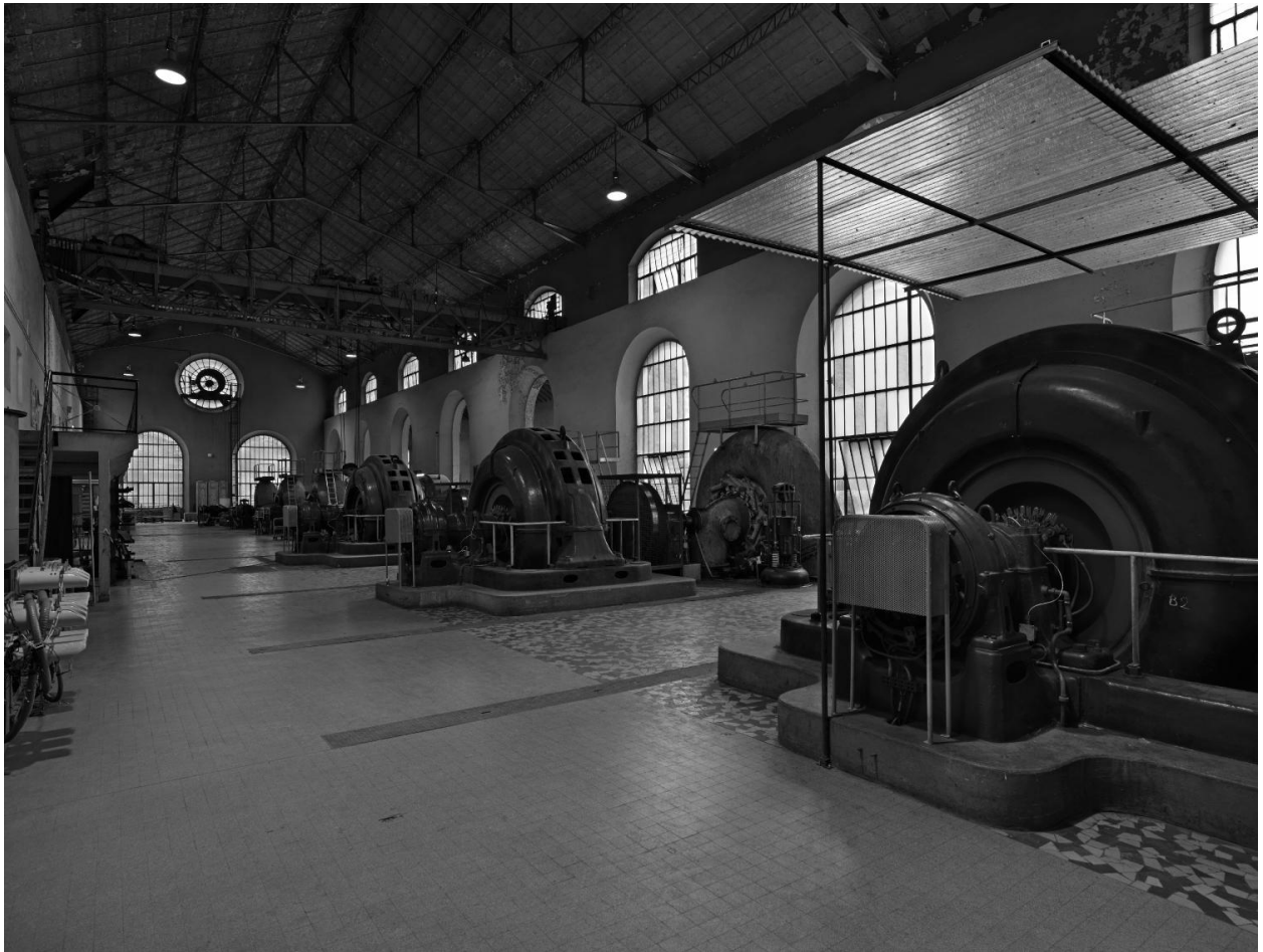
Vue intérieur de la centrale de Rioupéroux
