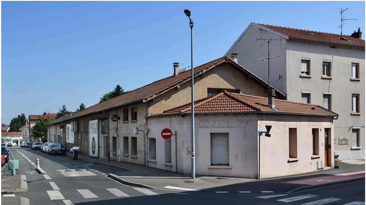
Vue d'ensemble de ce bâtiment tout en longueur
