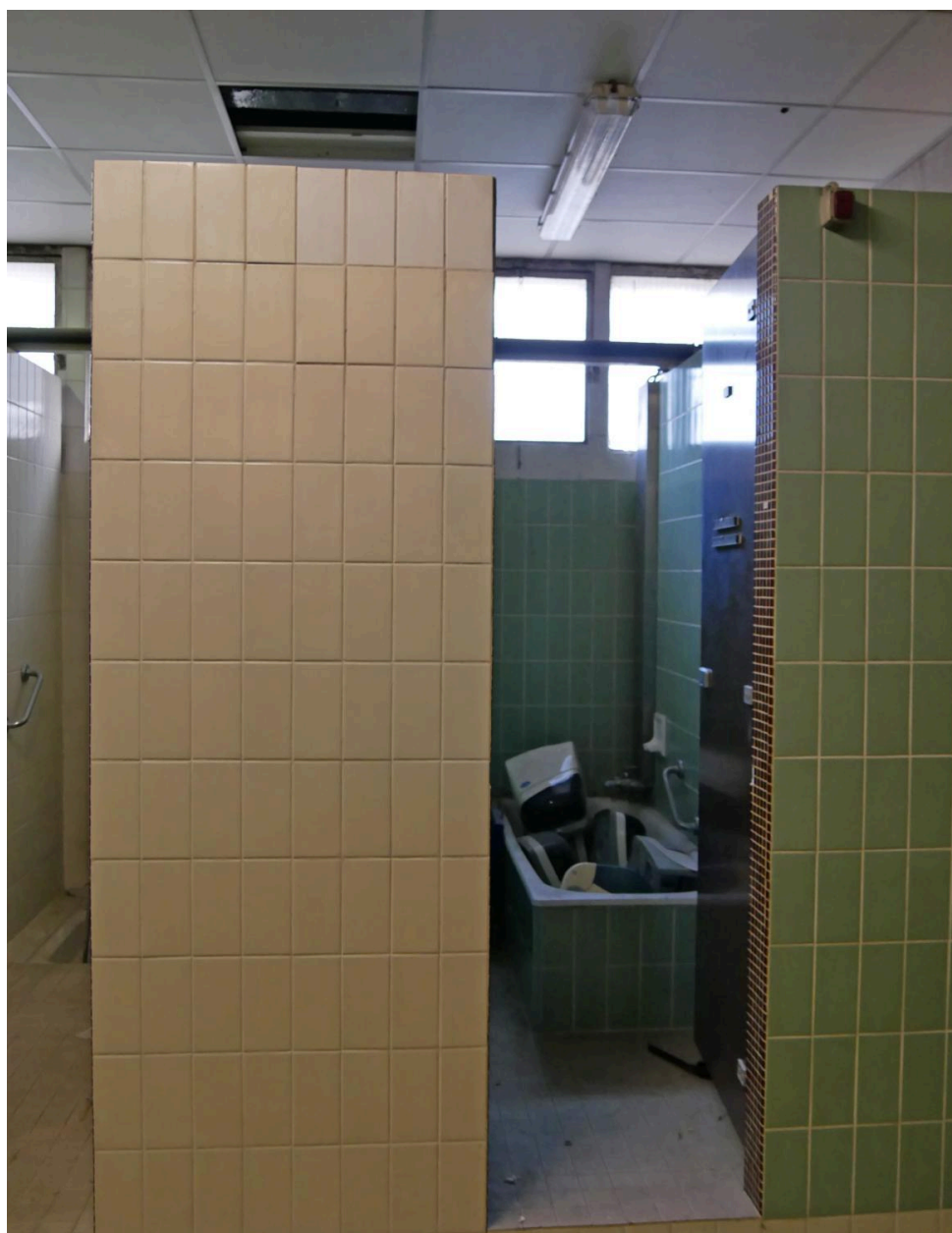
Détail cabine bains
