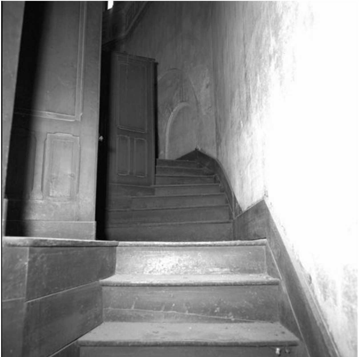
Chapelle : escalier desservant les gradins, état en 1984
