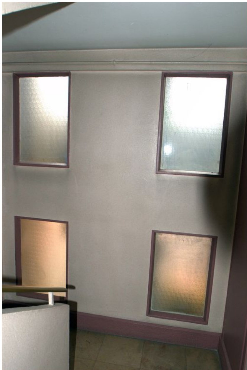
Les baies éclairant la cage d'escalier
