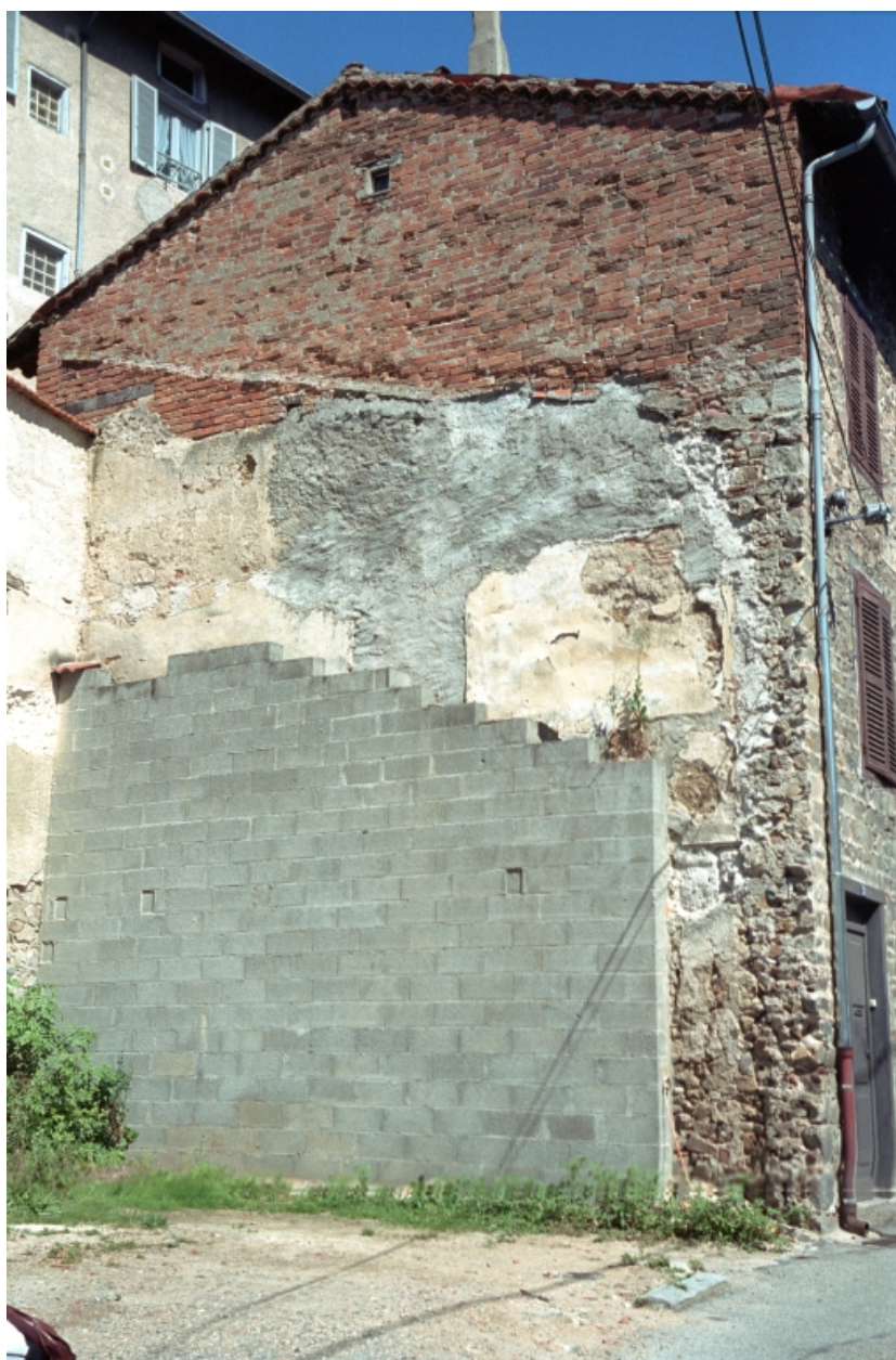
Boën, îlot 12, Ph. Raymond (rue) 21. Vue générale du mur pignon sur rue.
