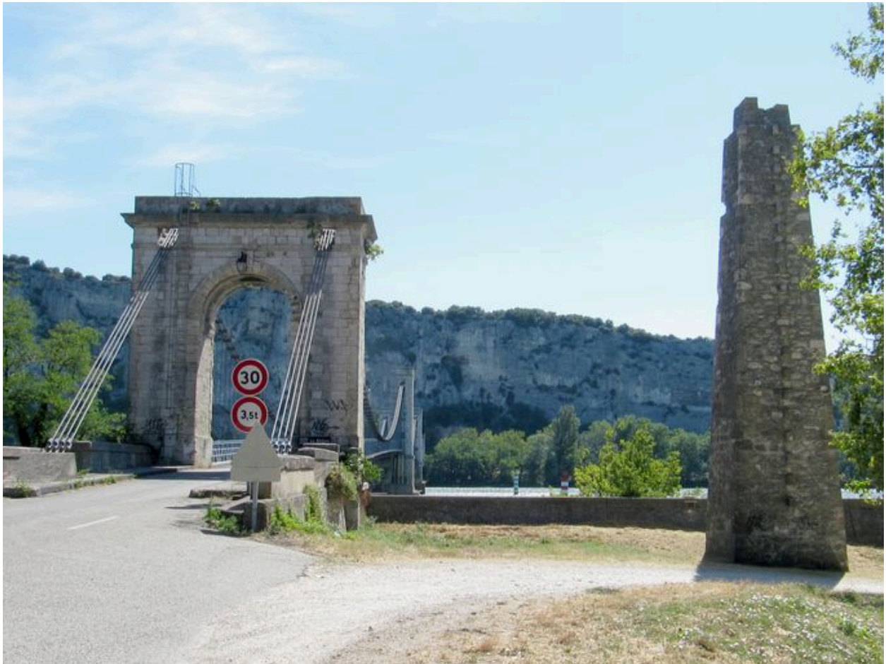
Pyramide de l'ancien bac, vue générale et vue de la tête de pont en arc monumental du pont du Robinet (rive droite, face ouest)
