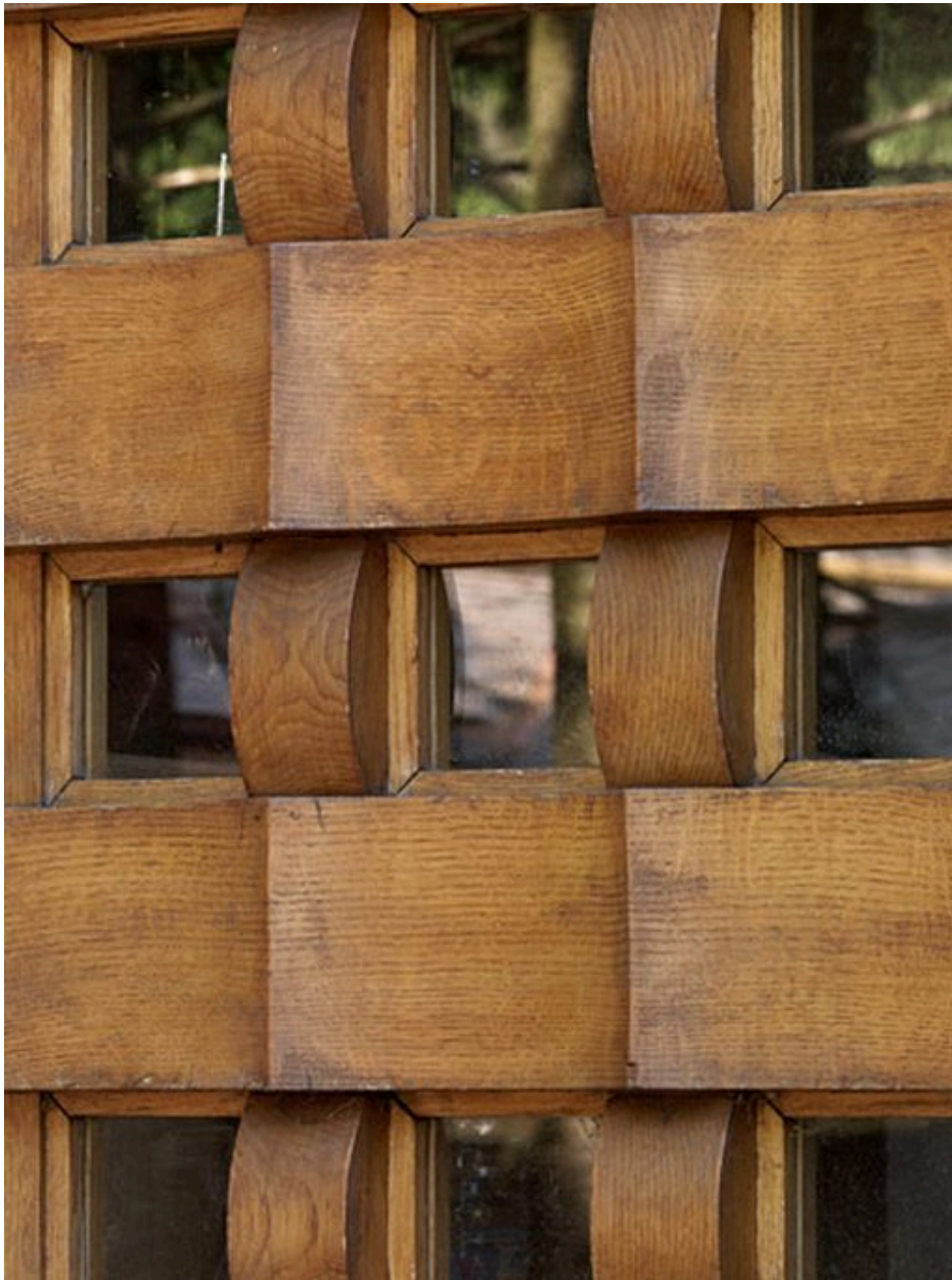
Détail de l'huisserie de la porte d'entrée
