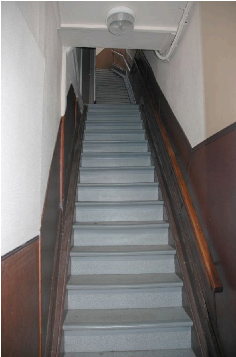
Escalier droit en bois, à deux volées entre-murs.
