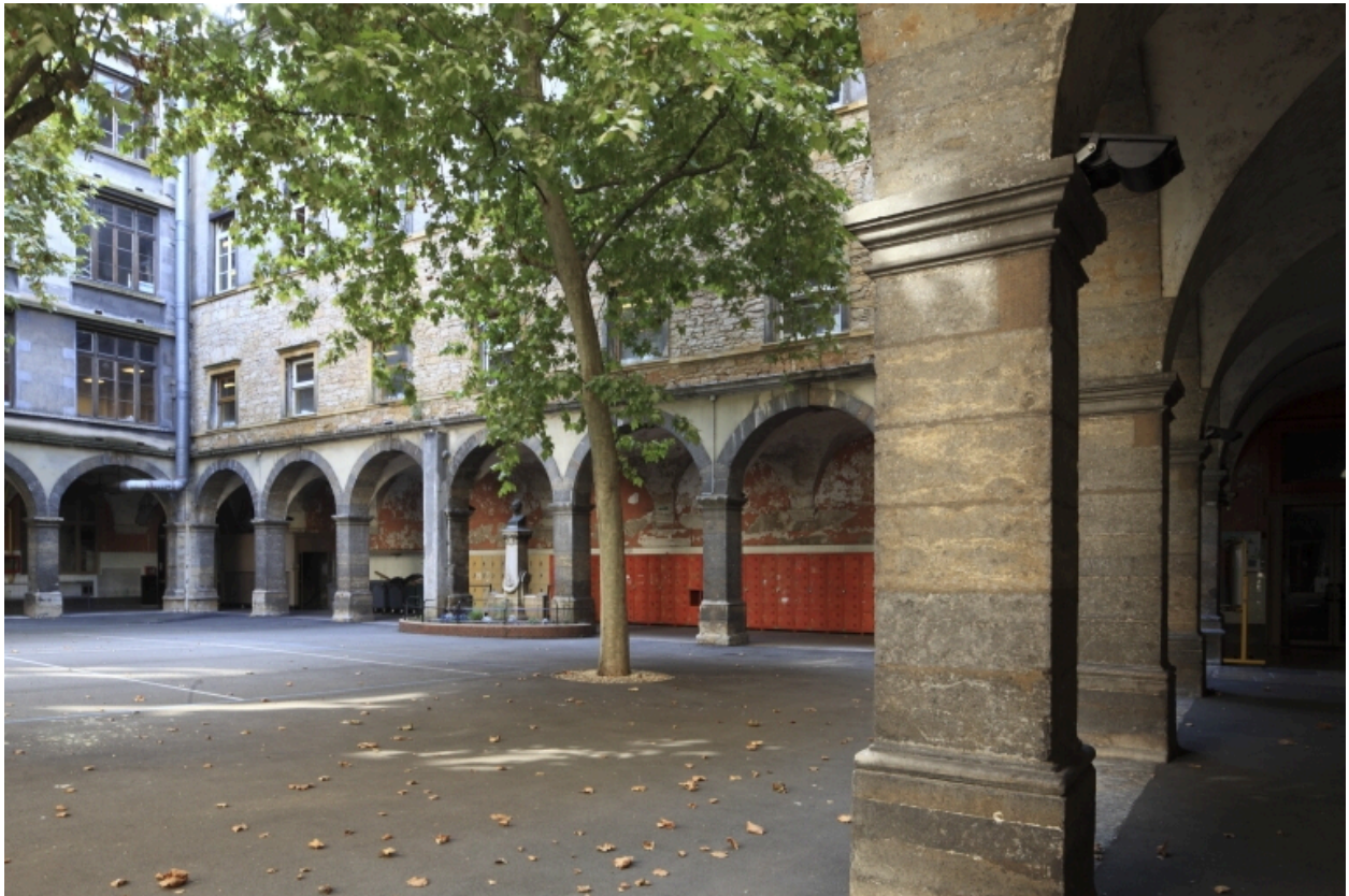
Cour du lycée. Façade nord.
