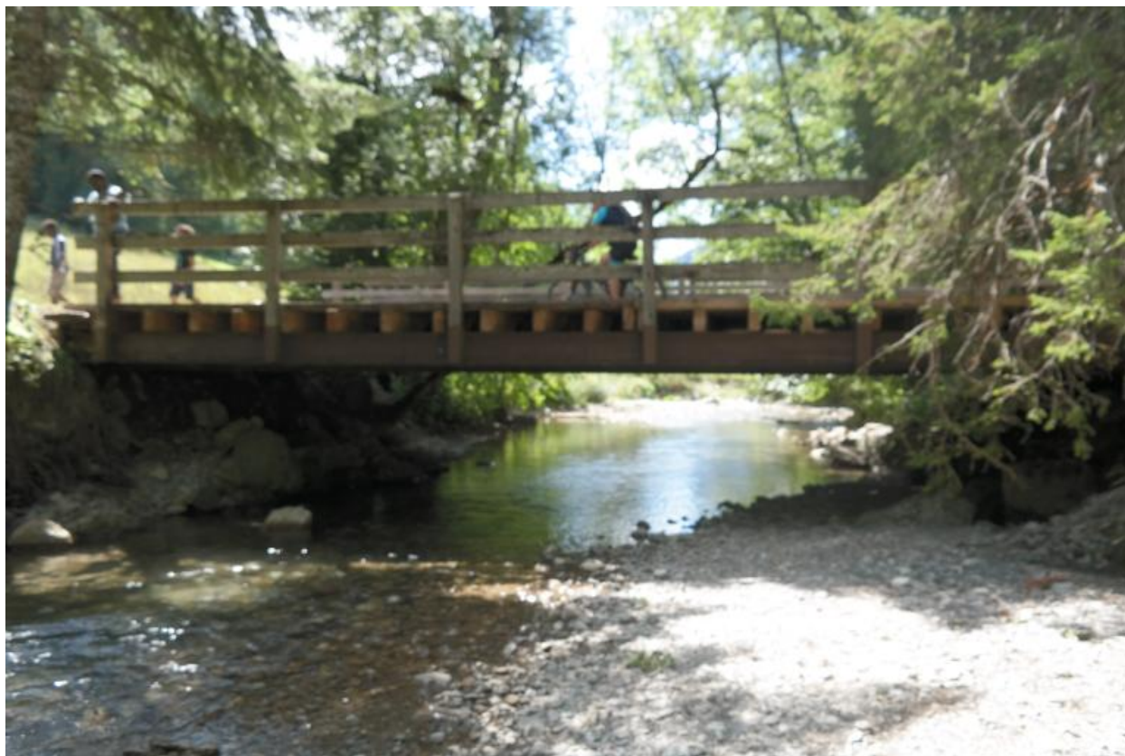
Pont du Banfin, face amont
