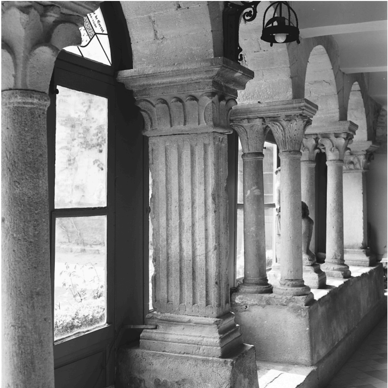
Vue partielle des vestiges, galerie nord-est.
