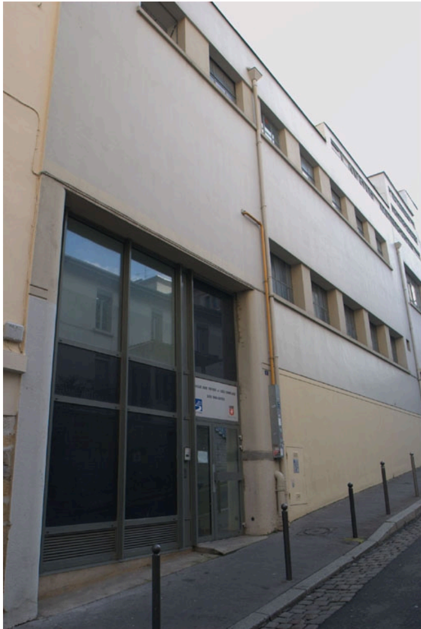
Entrée nord-est de la salle des Ovalistes
