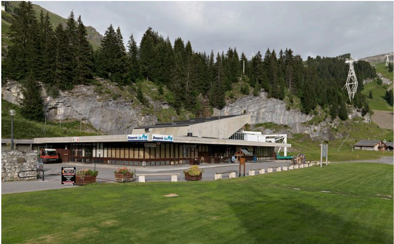
Vue depuis le sud-ouest
