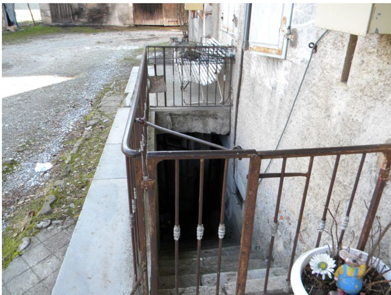
Descente d'escalier vers la cave.
