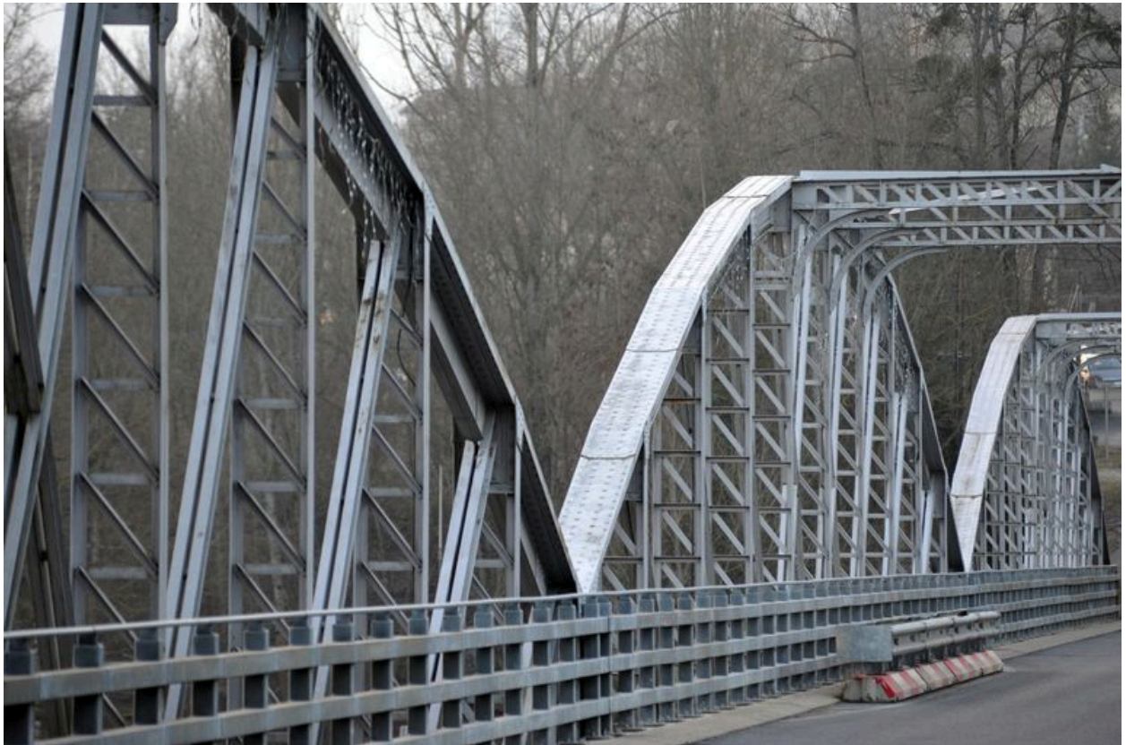
Vue partielle, de dessus, arches de la face aval (depuis la rive gauche)
