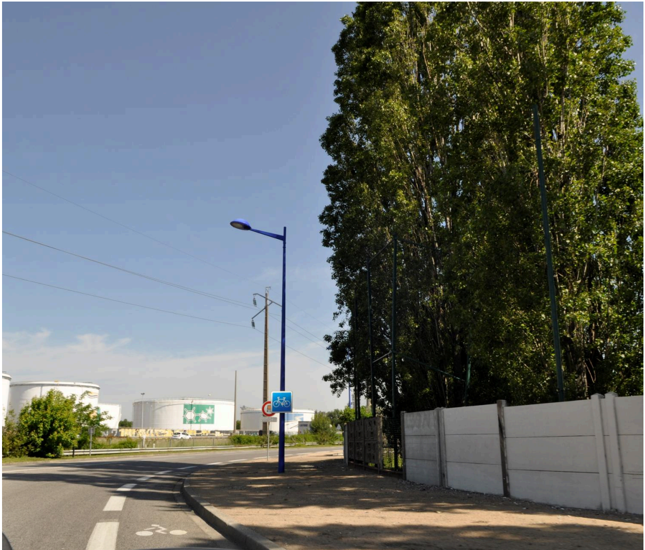
Cuves de stockage
