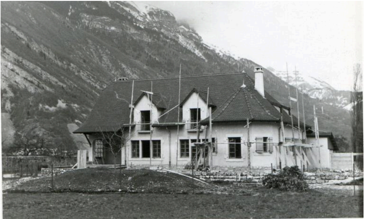
Vue d'ensemble avec les échafaudages lors de la construction.
