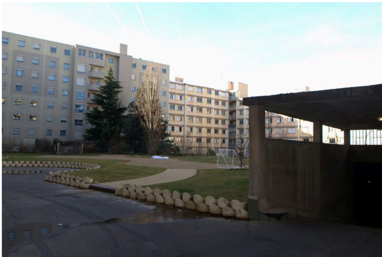
Vue de la cour, du jardin et de l'entrée des garages
