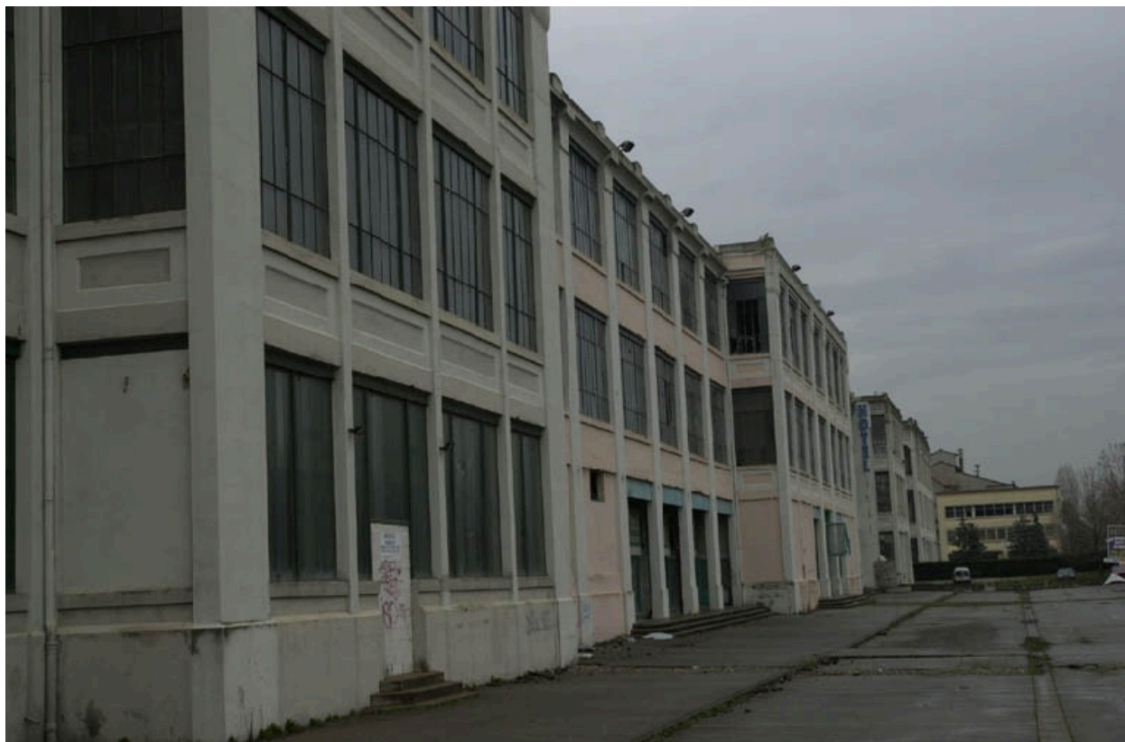
Détail façade principale, vue ouest
