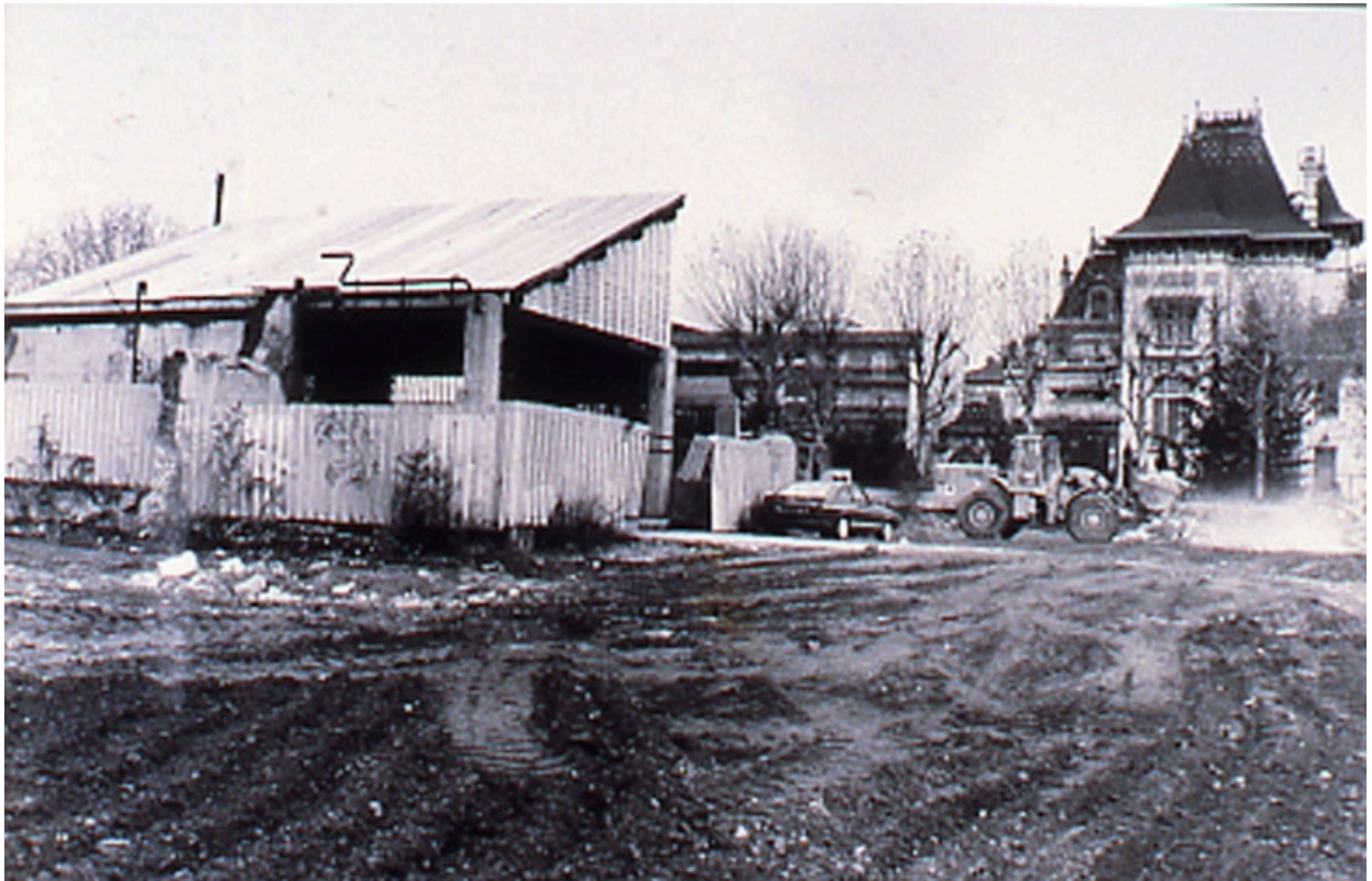
Travaux du hangar
