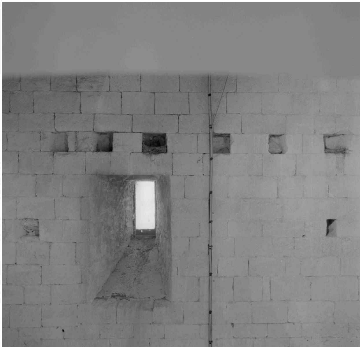
Détail de l'appareil à l'intérieur du donjon, une baie et des trous de boulins.
