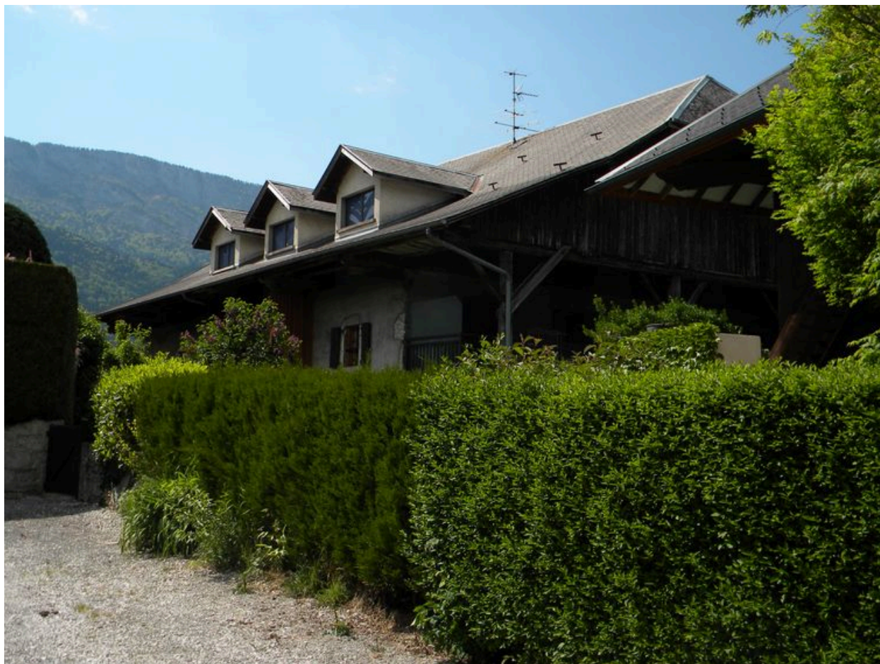
Façades sud et est d'une ancienne ferme avec un grand espace couvert sur le pignon est (C5 2945)
