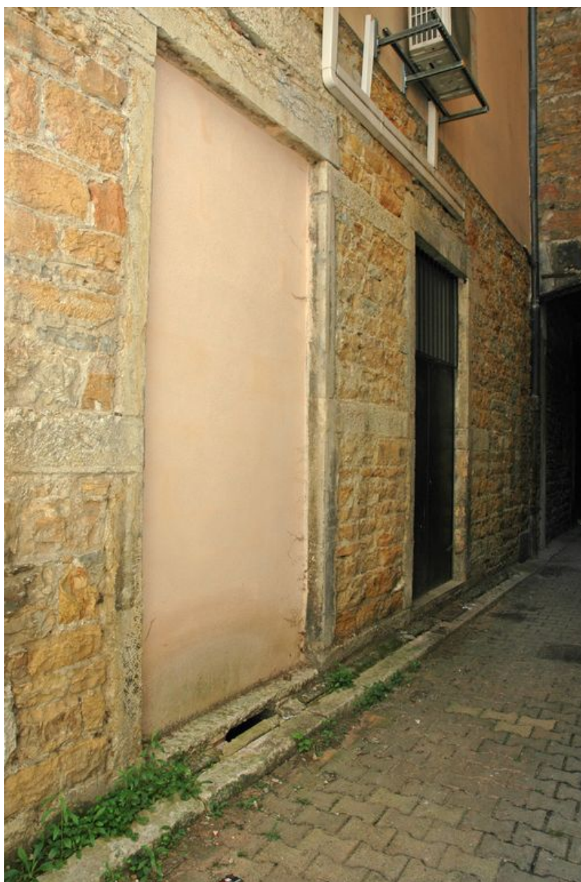
Détail du mur ouest et du caniveau longeant le passage du 95 Grande rue de la Guillotière depuis le nord
