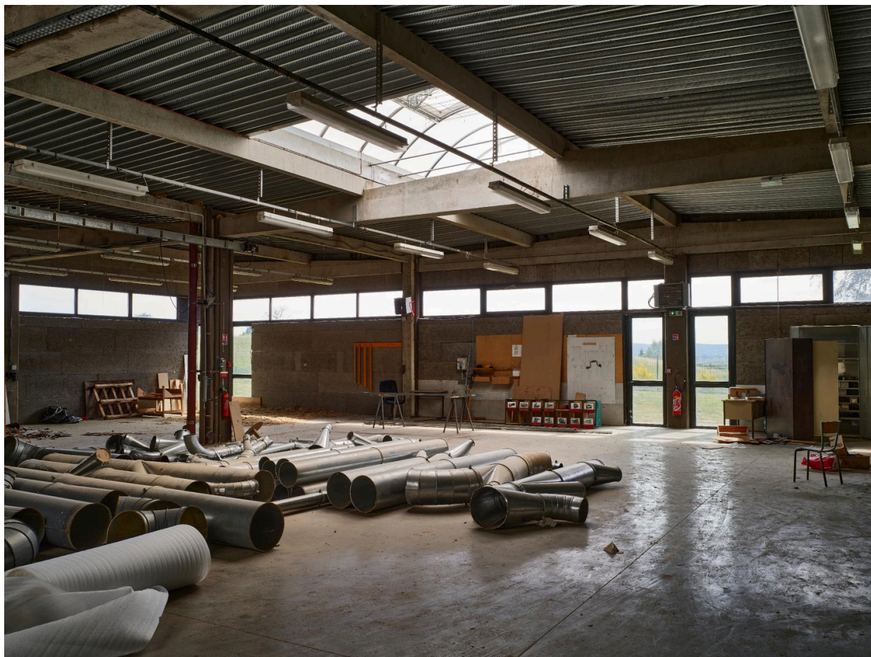
Bâtiment des ateliers, angle nord-est. Atelier de menuiserie en cours de désaffectation.
