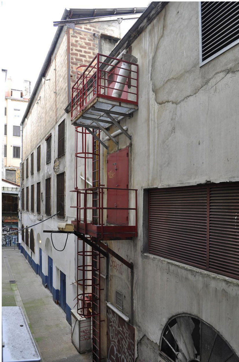
Vue d'ensemble du côté sud de la voie, depuis l'est
