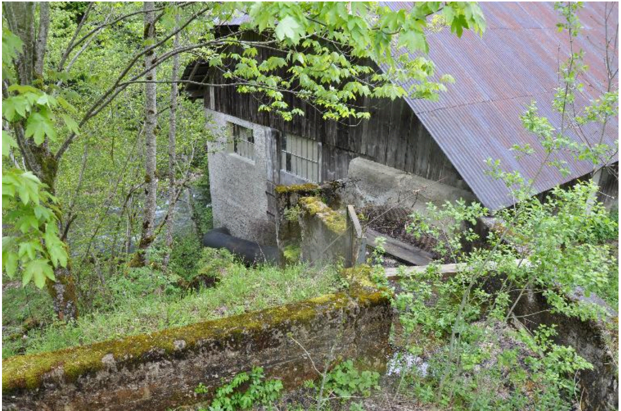
Vue de la chambre d'eau.
