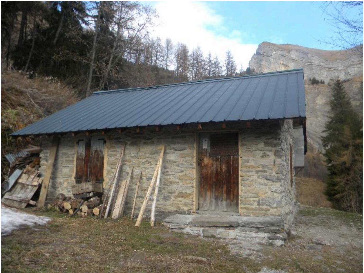
Vue de la façade principale du chalet sud.
