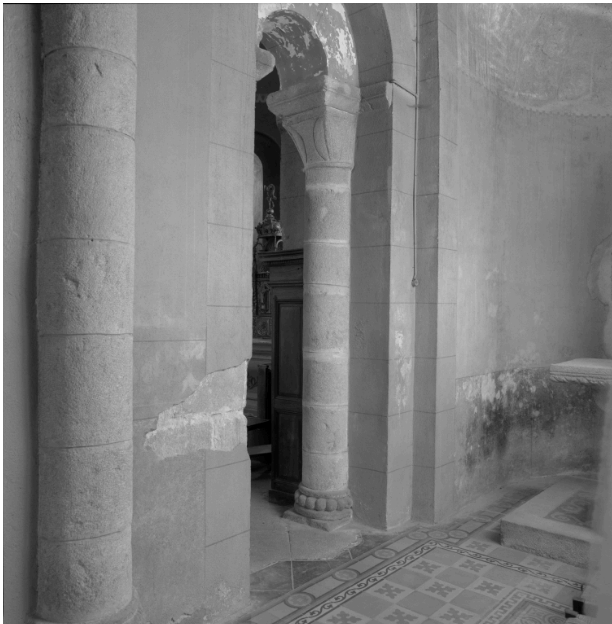
Vue du passage entre choeur et absidiole sud : chapiteau n°3, colonne et base.
