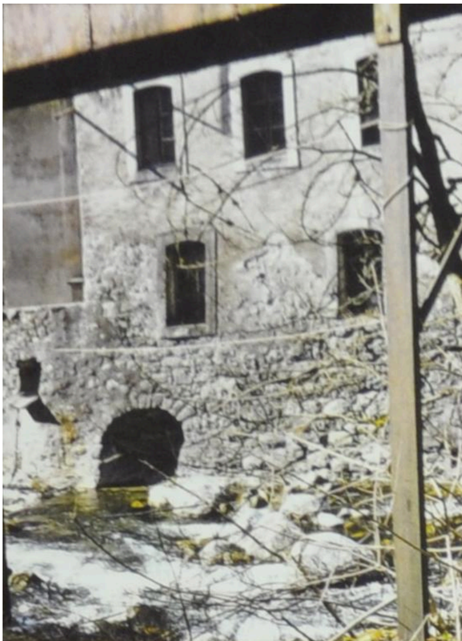
Canal de fuite de l'usine
