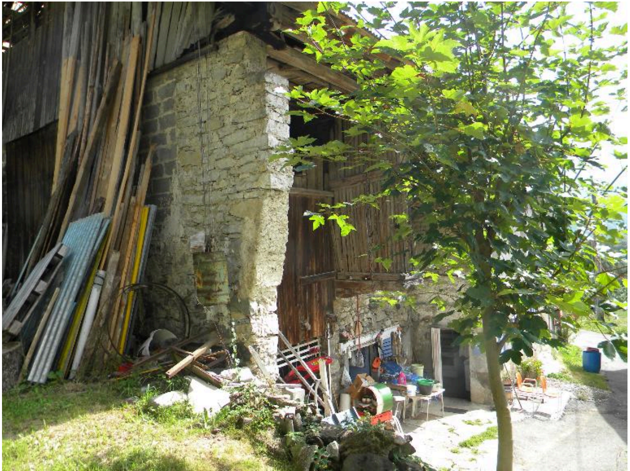
Vue de trois-quarts depuis l'amont.
