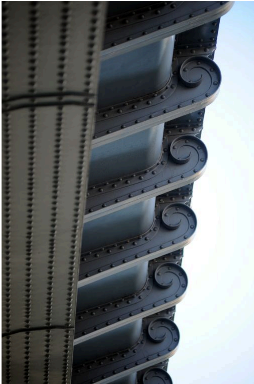
Arche, face amont, vue de détail : décors de l'accroche au tablier, de dessous (depuis la rive gauche)
