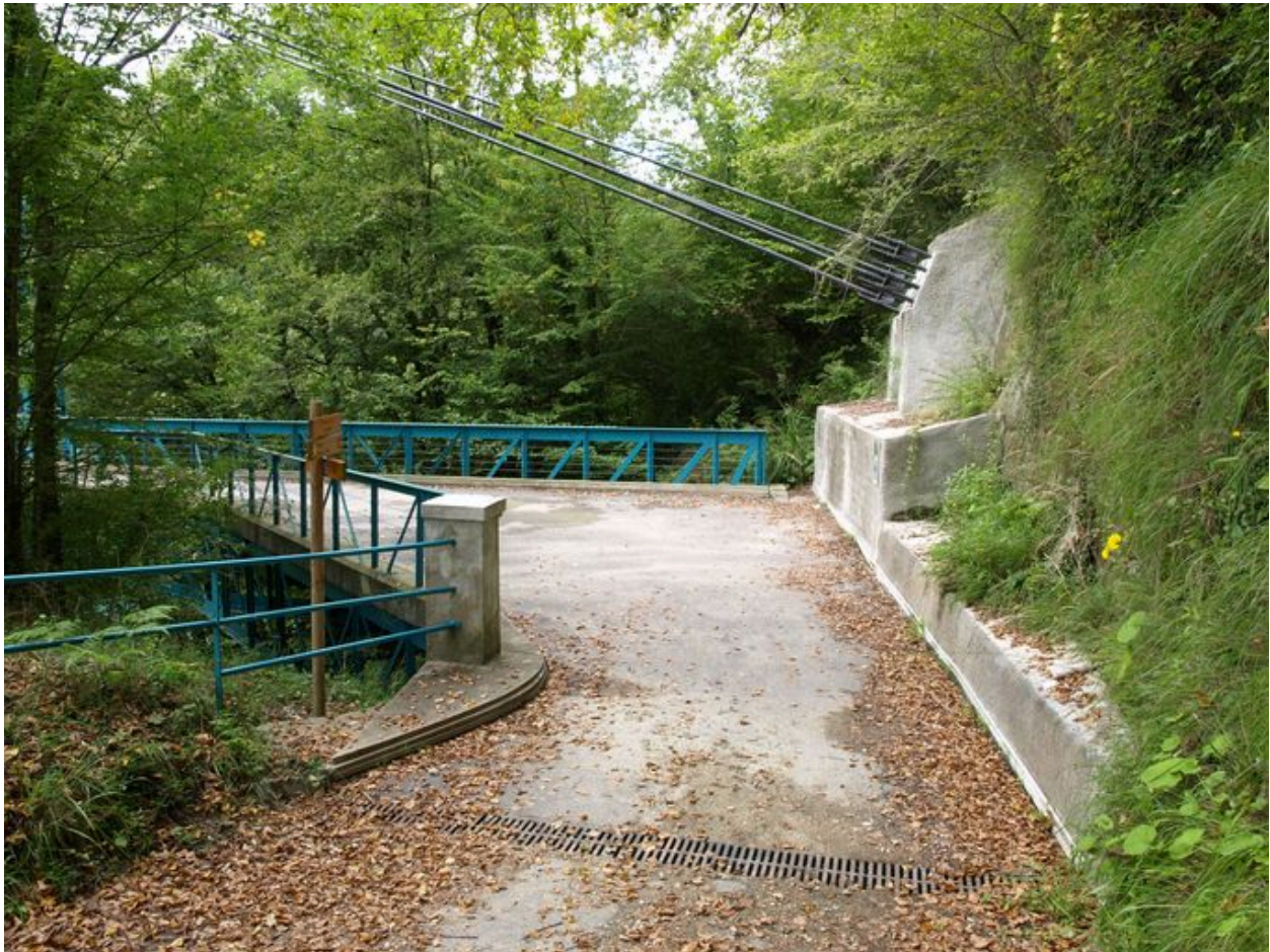
Rive droite : débouché du pont, massif et câbles d'ancrage, face amont
