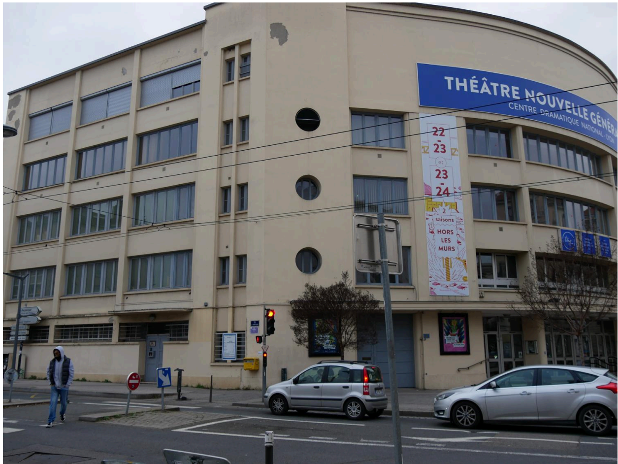
Baies oblongues en rez-de-chaussée des bains-douches Bourgogne
