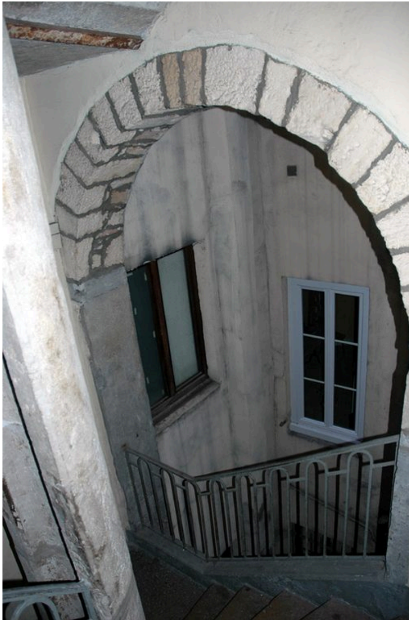
Couvent : 2 rue des Templiers, vue du seul arc dans l'escalier
