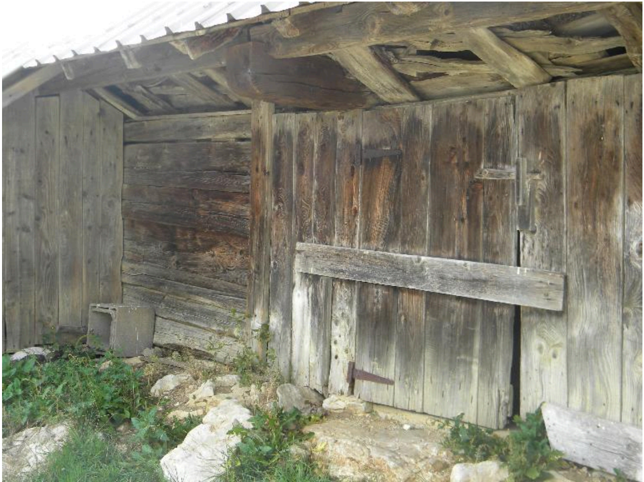
Vue des huisserie en façade de l'ancienne étable.
